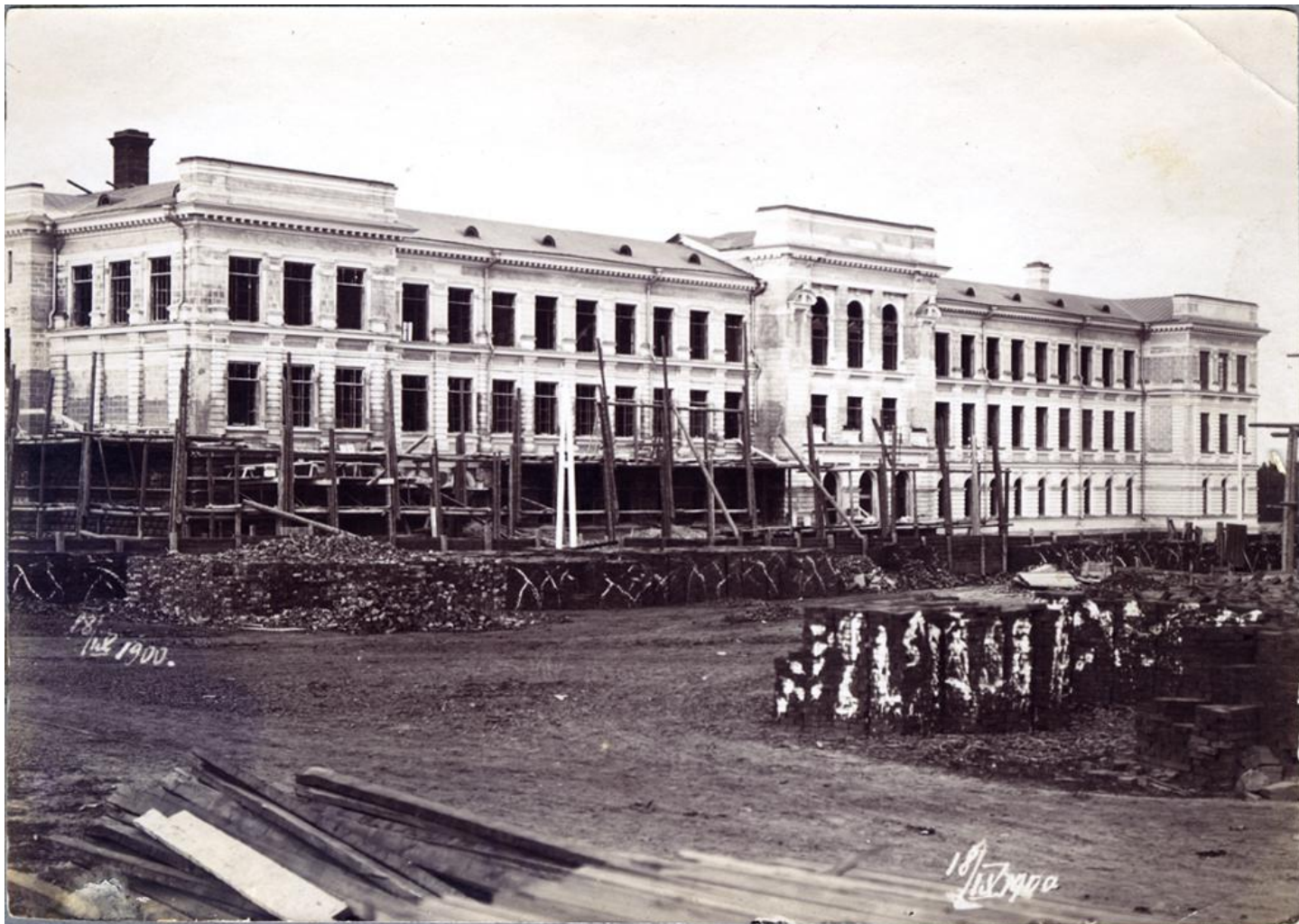
Строительство м. нагуча ТТУ 18/IX-1900.
