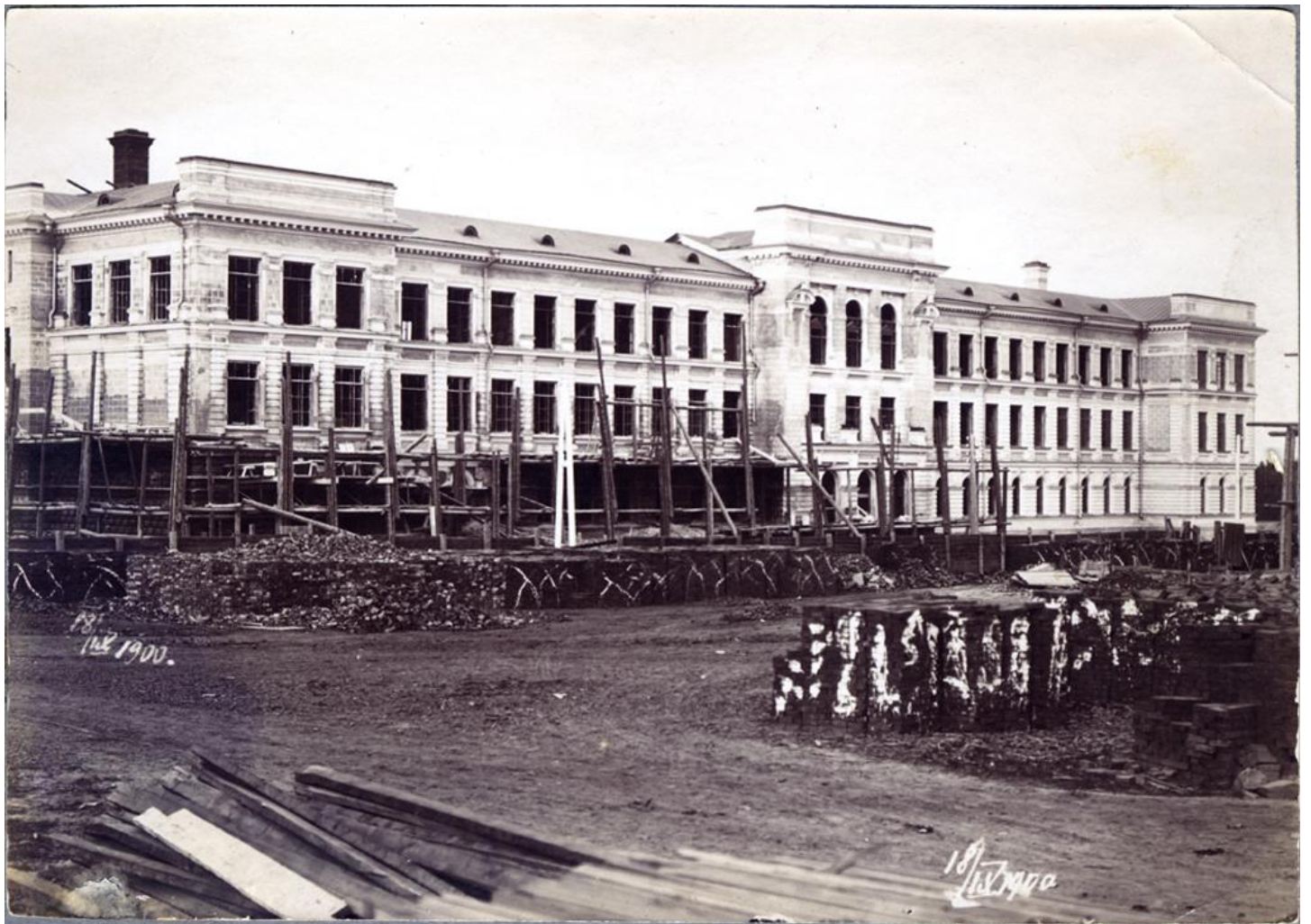
Строительство м. нагуча ТТУ 18/IX-1900 г.
